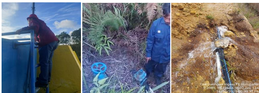
Gambar 37. Monitoring Jaringan Irigasi dalam Upaya Perbaikan Jaringan Irigasi, 15 Oktober 2025
