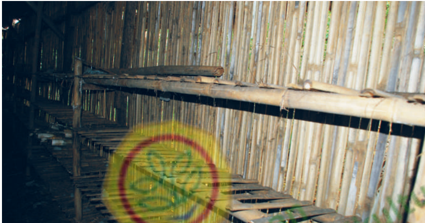
Kumbung berdinding anyaman belahan bambu
