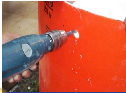
Proses melubangi tandon dengan mesin bor
