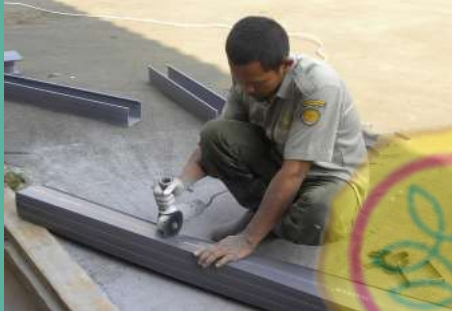
Pemotongan talang disesuaikan dengan panjang rangka holo pada tiap sisinya
