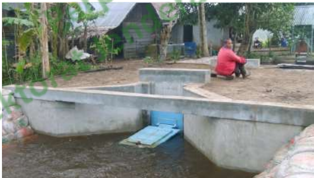
Gambar 7. Sistem pintu air makro di saluran primer yang masuk menuju saluran sekunder area lahan budidaya
