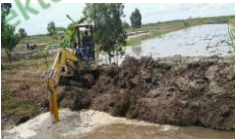
Gambar 6. Pemeliharaan surjan dengan menambahkan tanah dari tabukan menggunakan excavator
