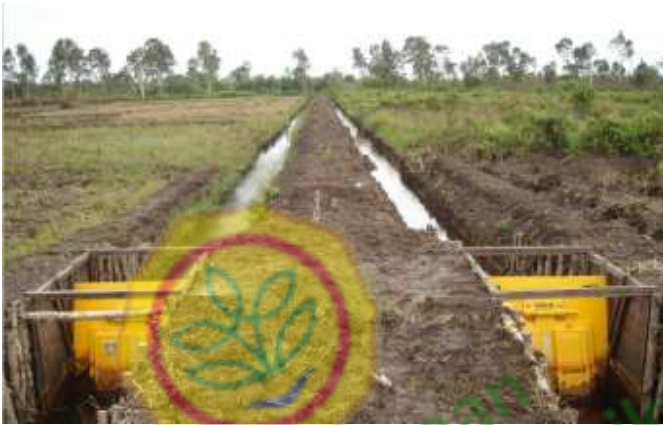
Gambar 8. Sistem pintu air mikro di saluran tersier yang masuk ke lahan budidaya
