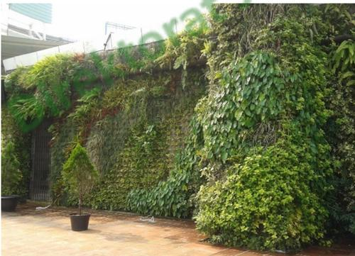
Gambar 4. Taman vertikal sistem sistem pocket menempel di dinding menggunakan kerangka baja ringan
